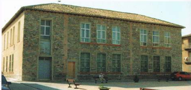
Edificio escolar construido en 1.888 en la calle Mediodía
