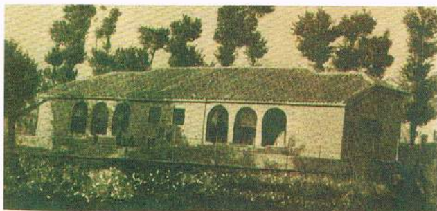
Edificio escolar construido en 1.930 en la Avenida de Monares
